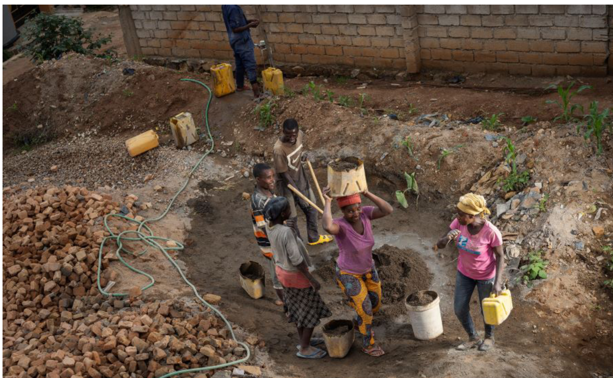
Bouwplaats Rwanda. Foto: Jan Banning
